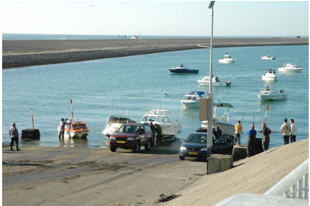
Figuur 3.5: De trailerhelling bij Neeltje Jans is een voorbeeld van een goed bruikbare trailerhelling.
